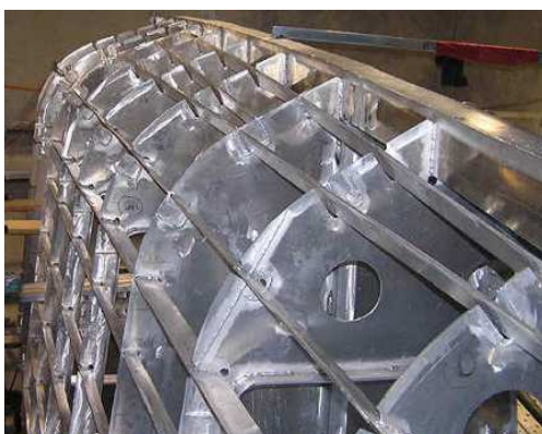
Figur 4-2: Aluminiumskrog, platespant og langskips stivere før hudplate legges på
