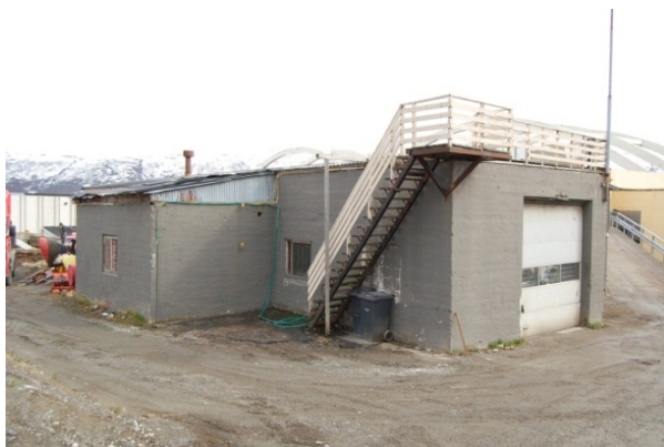
Bygningen sett fra nordvest
