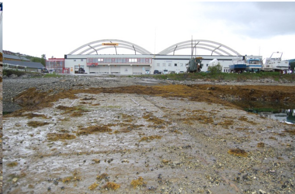
Betongplanet sett oppover (fra sørøst)
