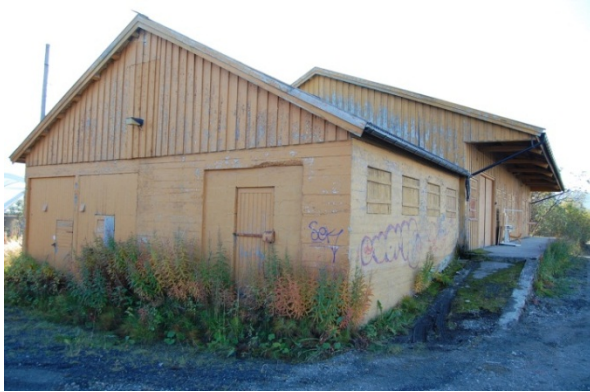
Jernbanebrakka (11) sett fra nord
