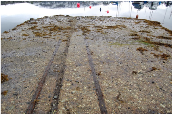
Betongplanet ned mot sjøen
