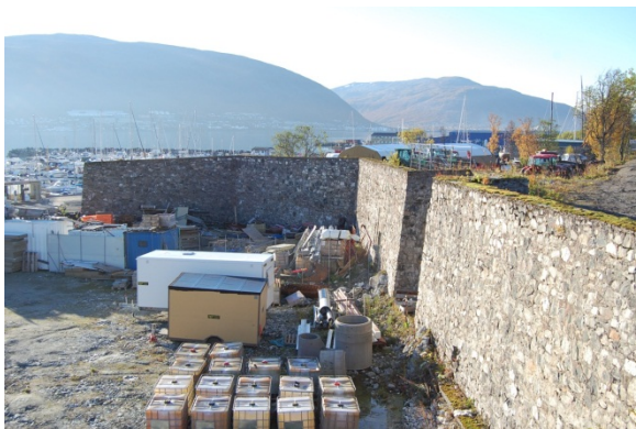
Splintmuren sett fra nord
