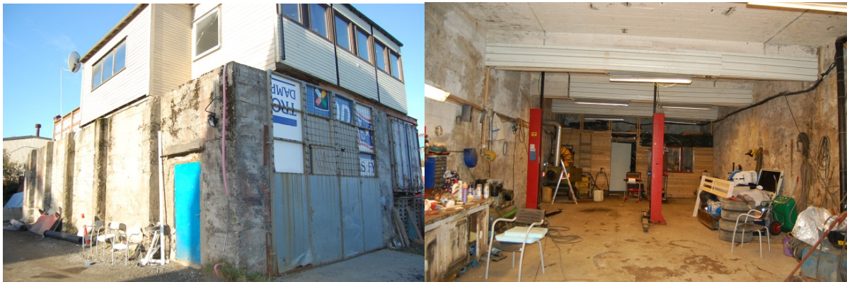
Bunkeren sett fra øst
