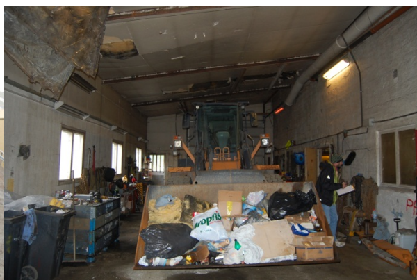
Inne i tilbygget. Oppr. yttervegg til høyre
