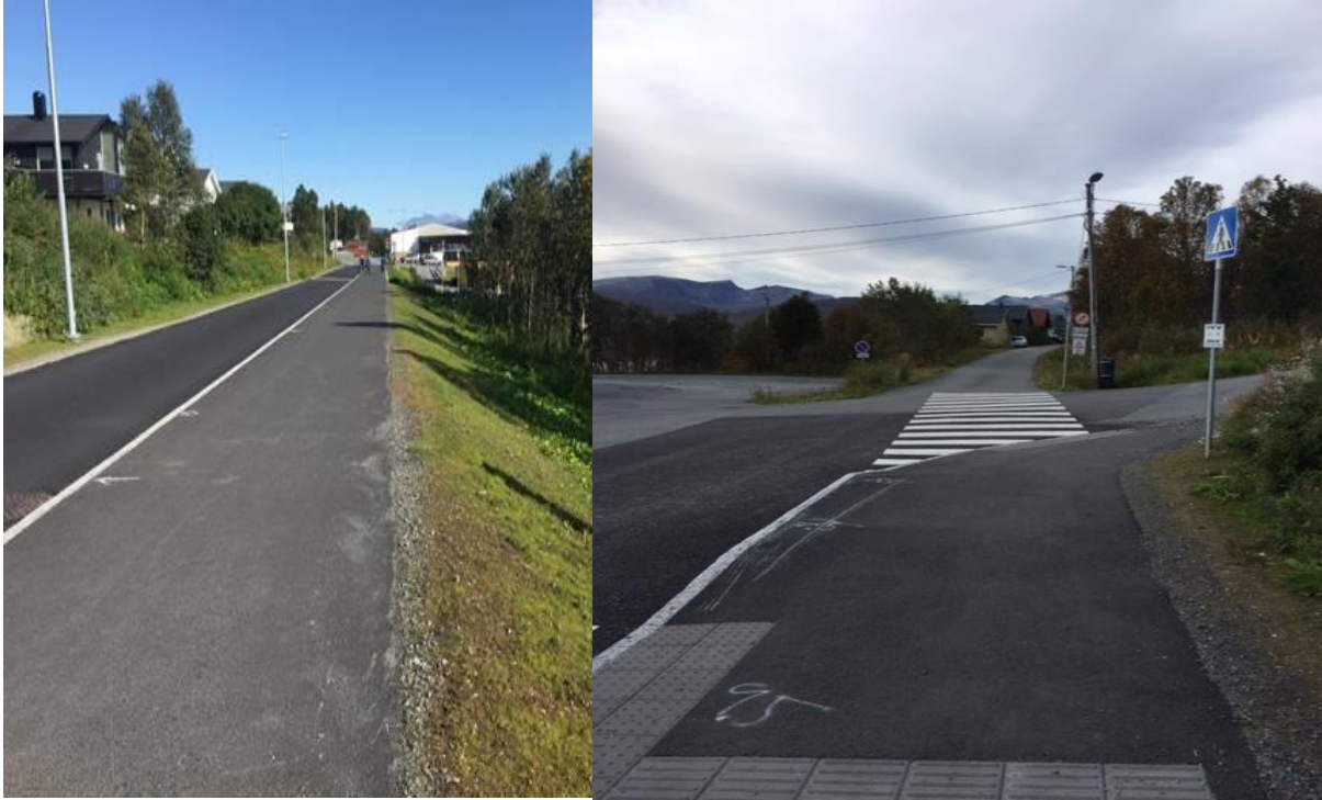
Mål: Oppgradering av dagens kollektivfelt med blant annet breddeutvidelse og fortau fra Blåselvegen til Selnes skole. Fremdrift: Ferdigstilt.
