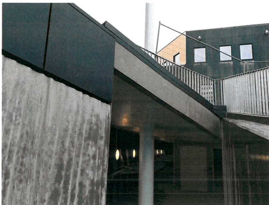
Bilde av inngang til værbeskyttet, «som bygget» sykkelparkering.
