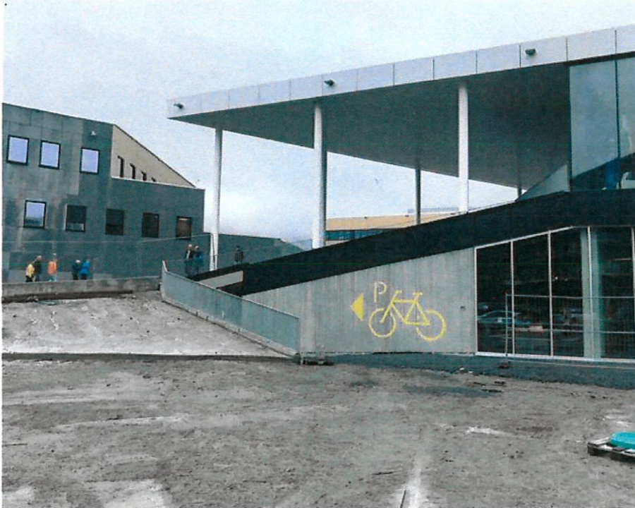
Inngang fra torg 1 til sykkelparkering under tak.
